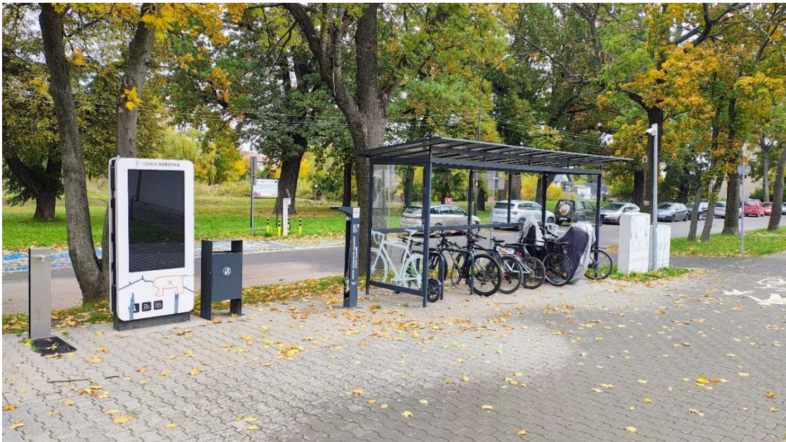
Rysunek 23. Gmina Sobótka – parking P+R oraz B+R przy przystanku kolejowym Sobótka
