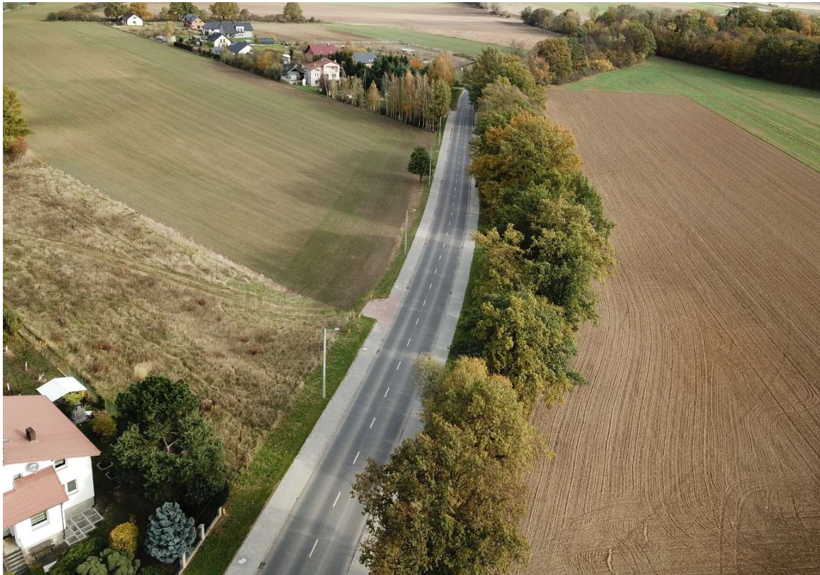
Rysunek 15. Gmina Mietków – modernizacja ul. Kąteckiej
