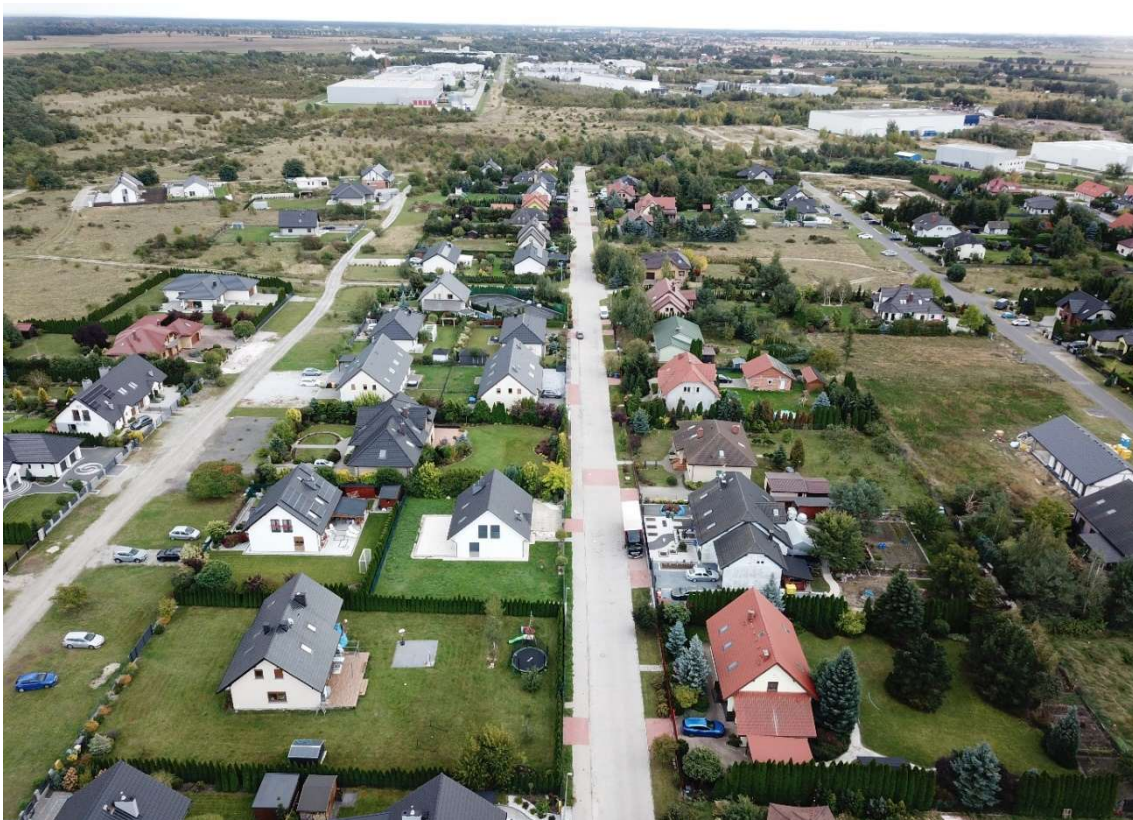
Rysunek 36. Gmina Oława – przebudowa ul. Modrzewiowej w Marcinkowicach
