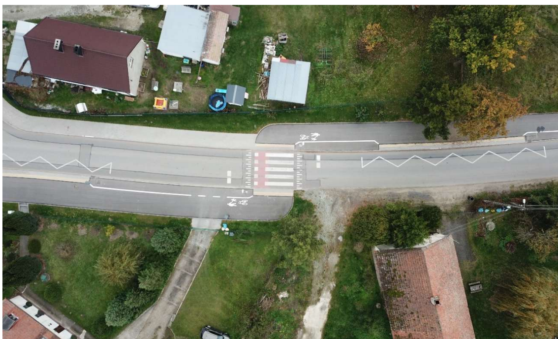
Rysunek 26. Gmina Oleśnica – przebudowa drogi powiatowej 1474 P
