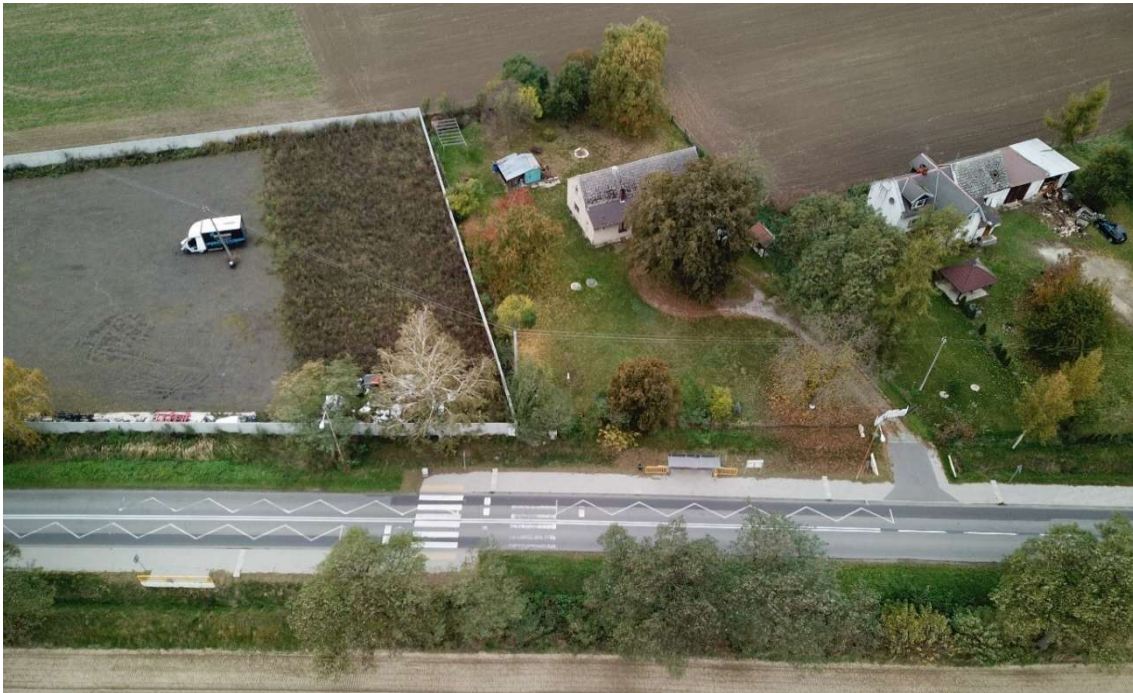
Rysunek 35. Gmina Dobroszyce – budowa chodnika i infrastruktury przystankowej
