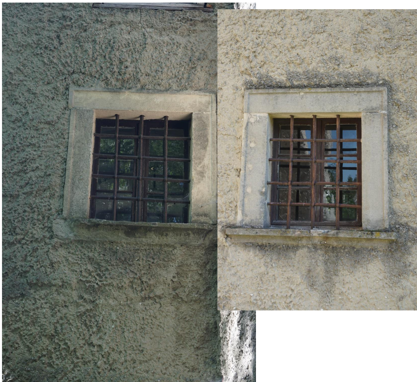
8. Kościół filialny pw. św. Jadwigi w Dobroszowie, piaskowcowe portale obramienia okienne wraz zachowanymi oryginalnymi, XVIII- wiecznymi kratami, fot. Piotr Pelc.
