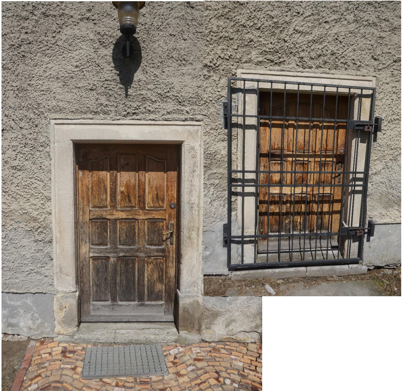
7. Kościół filialny pw. św. Jadwigi w Dobroszowie, piaskowcowe portale wejściowe wraz z wtórną stolarką drzewianą., fot. Piotr Pelc
