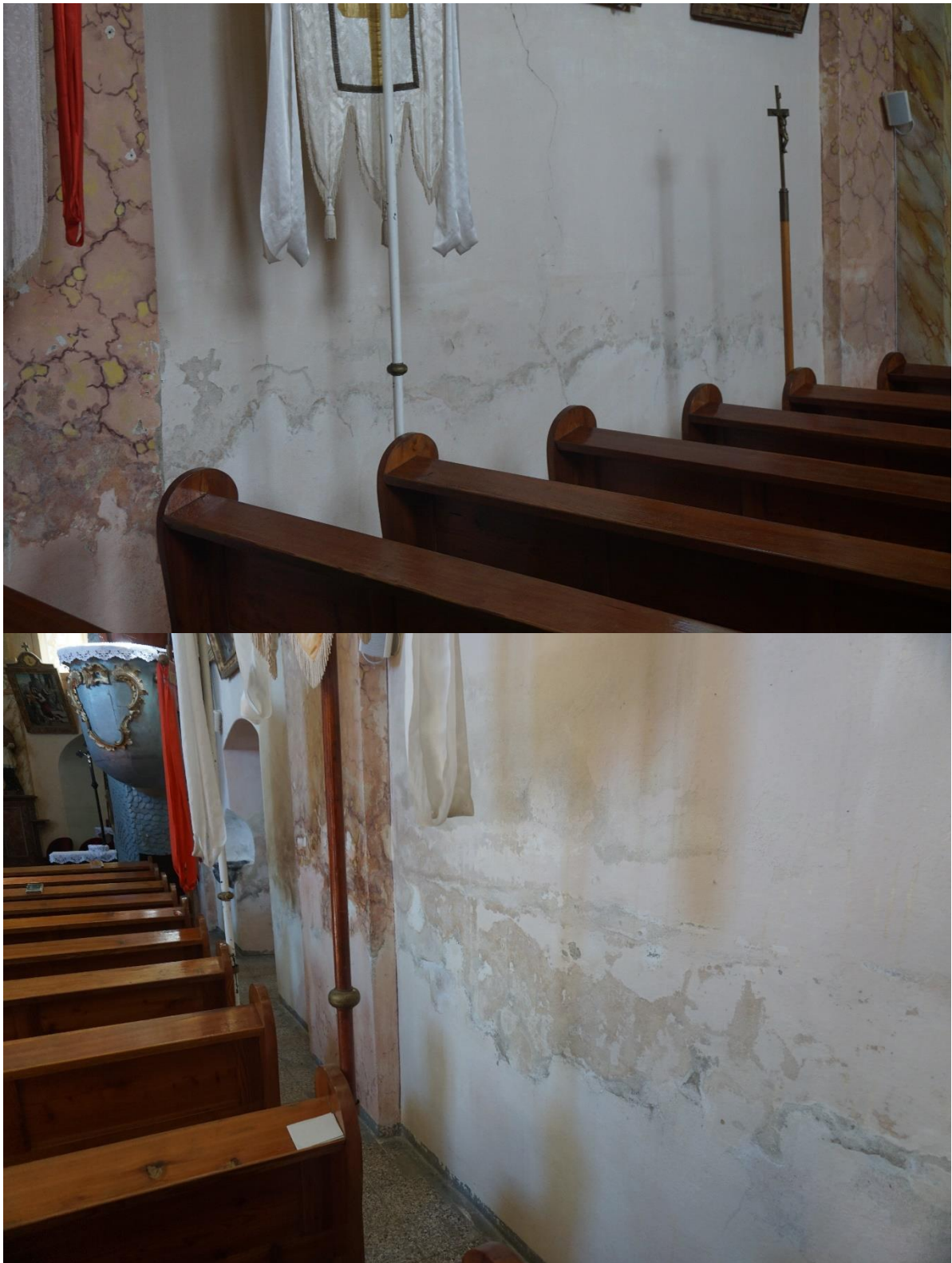
9. Kościół filialny pw. św. Jadwigi w Dobroszowie, wewnątrz kościoła, na zdjęciu widoczne silnie zawilgocone, zasolone i odparzone tynki., fot. Piotr Pelc.
