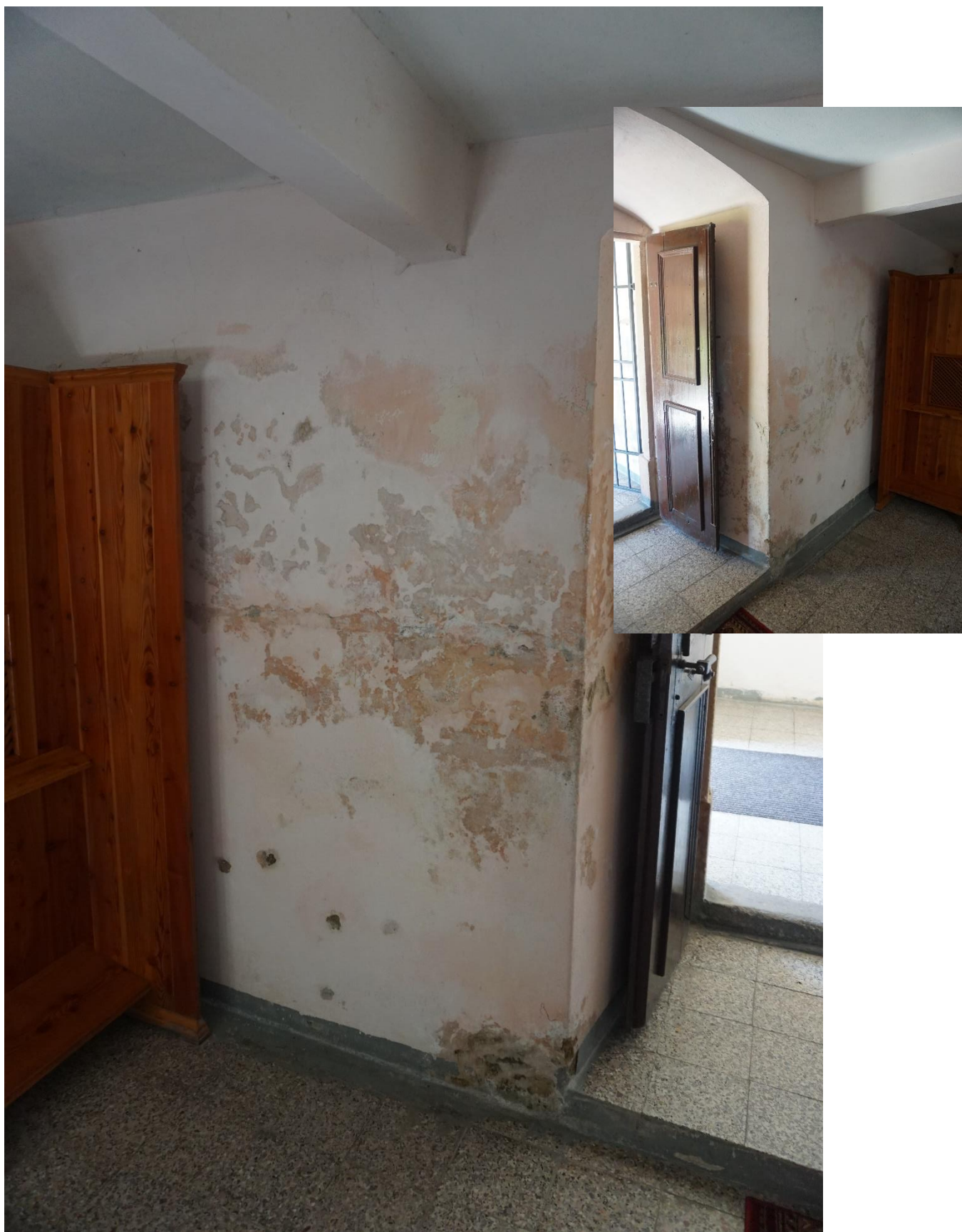
10. Kościół filialny pw. św. Jadwigi w Dobroszowie, wnętrze kościoła, na zdjęciu widoczne silnie zawilgocone, zasolone i odparzone tynki., fot. Piotr Pelc.
