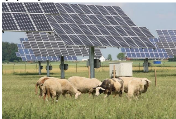
Rysunek 11 Farma fotowoltaiczna Kobern-Gondorf (lewej stronie) Rysunek 12 Zastosowanie rozwiązania agrofotowoltaiki w ramach farmy fotowoltaicznej Unterböcklenlohe (po prawej)
